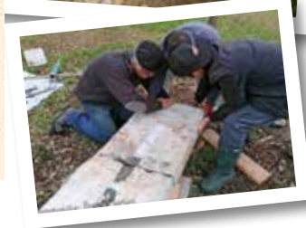
Le lavoir vu d'en haut, et la réparation d'une pierre de lavage.
