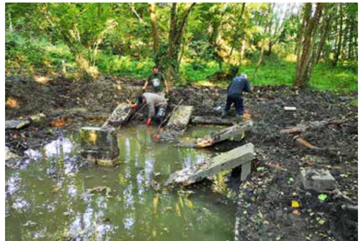
Curage et évacuation de l'eau pour assèchement du lavoir.
